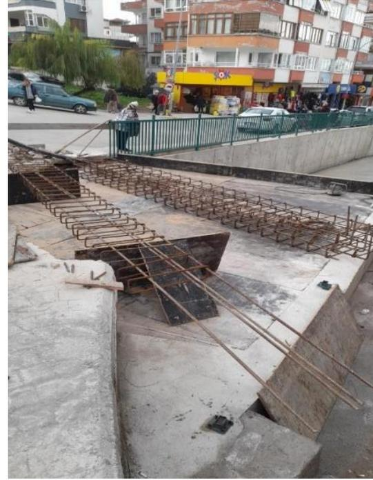
Bu kapsamda köprü imalatında 4 ton demir, 15 m<sup>3</sup> hazır beton kullanılmıştır.
