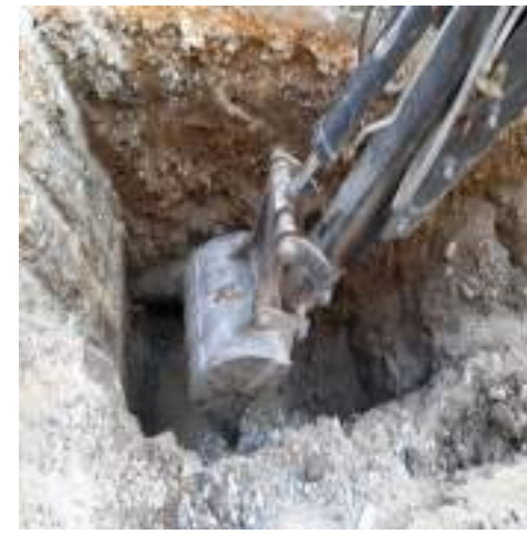
Bilgin Sokak, Ø 300'lük kanalizasyon hattı onarımı
