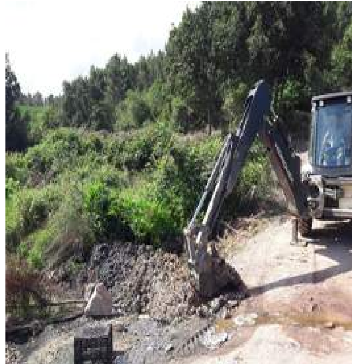
İlçe genelinde kanalizasyon hattı onarım çalışmaları
