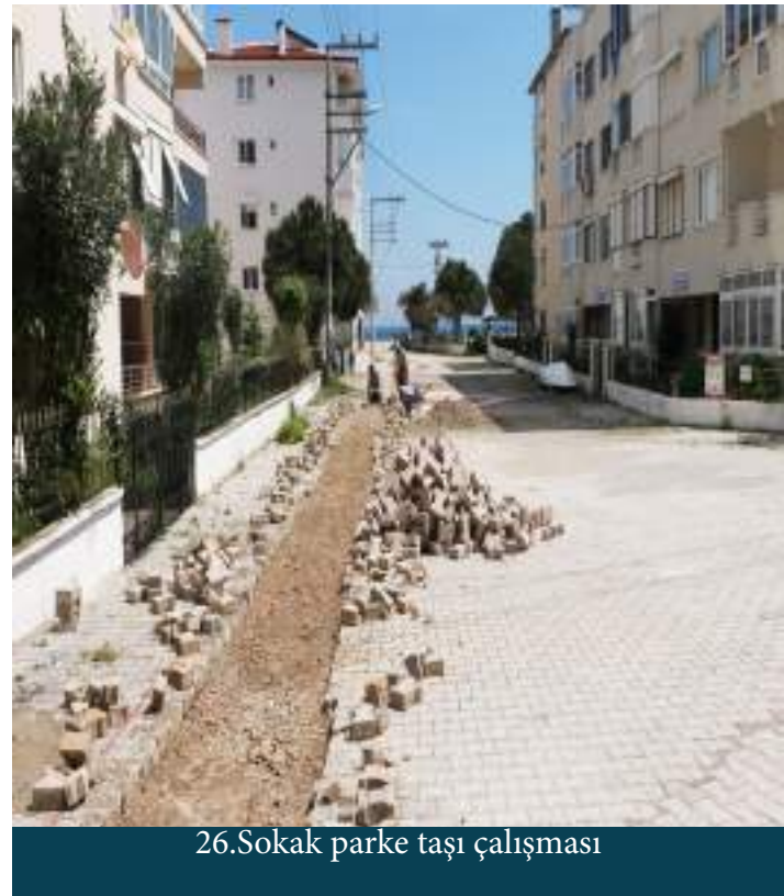
Harmanlar Mahallesi, 235. Sokak'ta yağmur ızgarası yapımı çalışması
