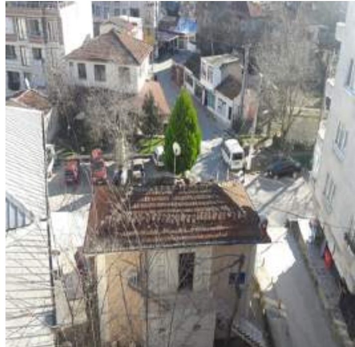
Harmanlar Muhtarlık Binası'nda çatı akmasından dolayı çatı olukları değişimi, çatı aktarımı ve kiremitlerin değişim çalışması
