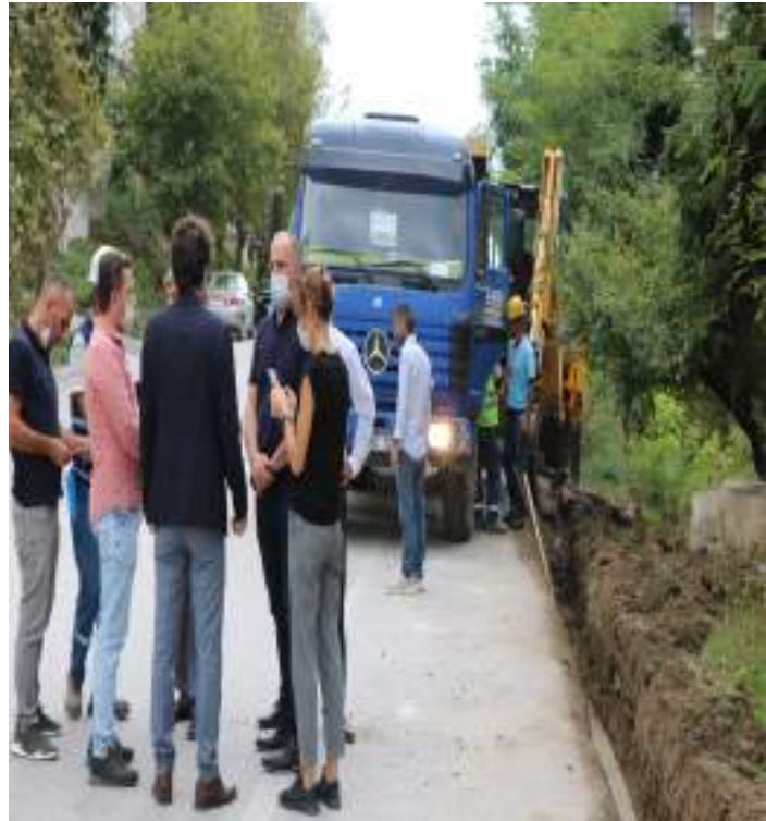
Elektrik hatlarının yeraltına alınması çalışması
