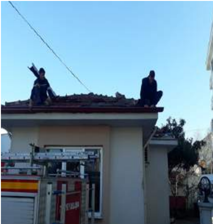
Taşlıman Muhtarlık Binası'nda çatı olukları değişimi, çatı aktarımı ve kiremitlerin değişim çalışması
