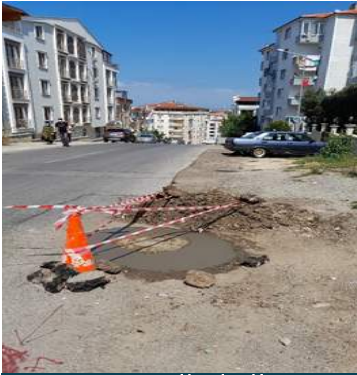
Mevcut muayene ve parsel bacası kapaklarının revize edilmesi çalışması
