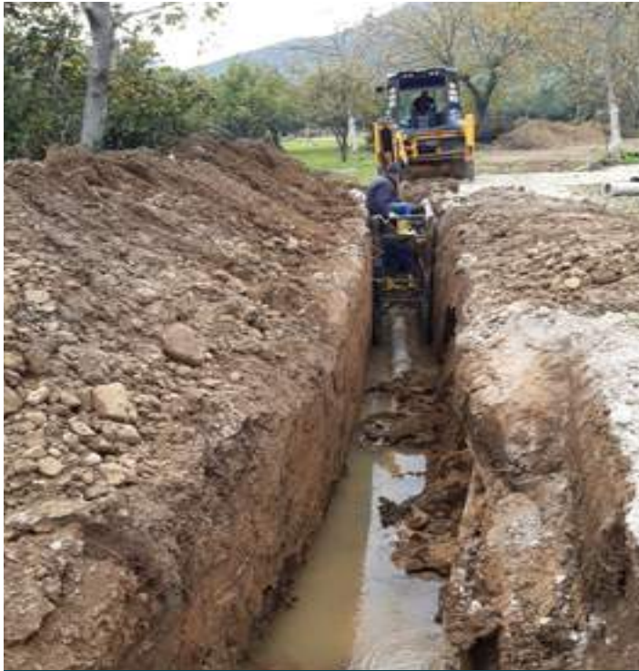
Karpuzdere Mahallesi, 24., 30., 31., 32. Sokaklar yeni kanalizasyon hattı çalışması
