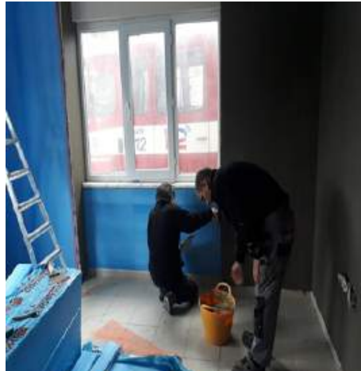
Taşlıman Muhtarlık Binası'nda çalışması
