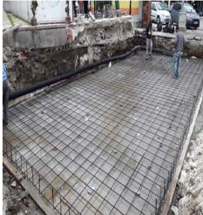
Belediye tuvaleti yenileme çalışması
