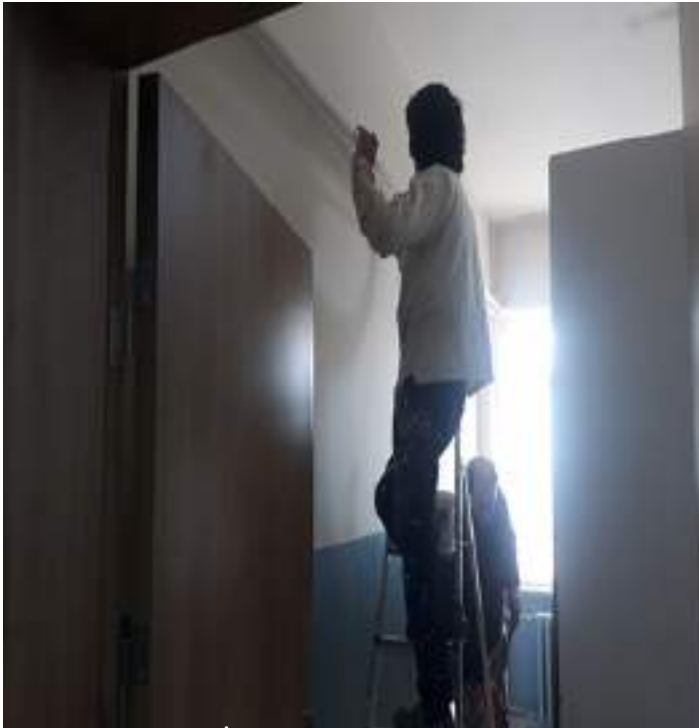
Firuzan Kınal İlköğretim Okulu bakım ve onarım çalışması
