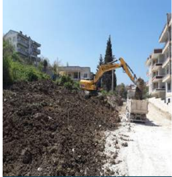
Yeni yol açma çalışmaları
