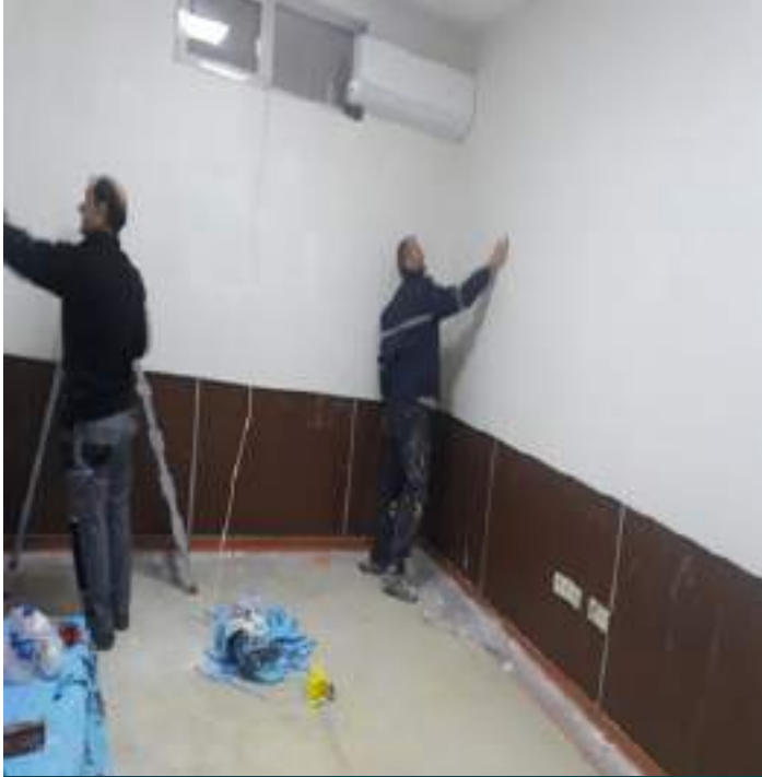
Çınarcık Devlet Hastanesi morg bölümü bakım ve onarım çalışması
