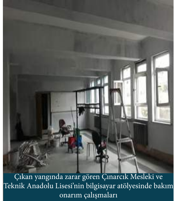
Çıkan yangında zarar gören Çınarcık Mesleki ve Teknik Anadolu Lisesi'nin bilgisayar atölyesinde bakım onarım çalışmaları
