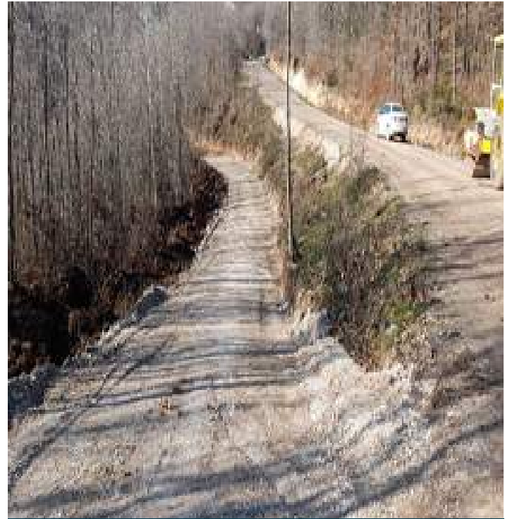
Yeni yol açma çalışmaları
