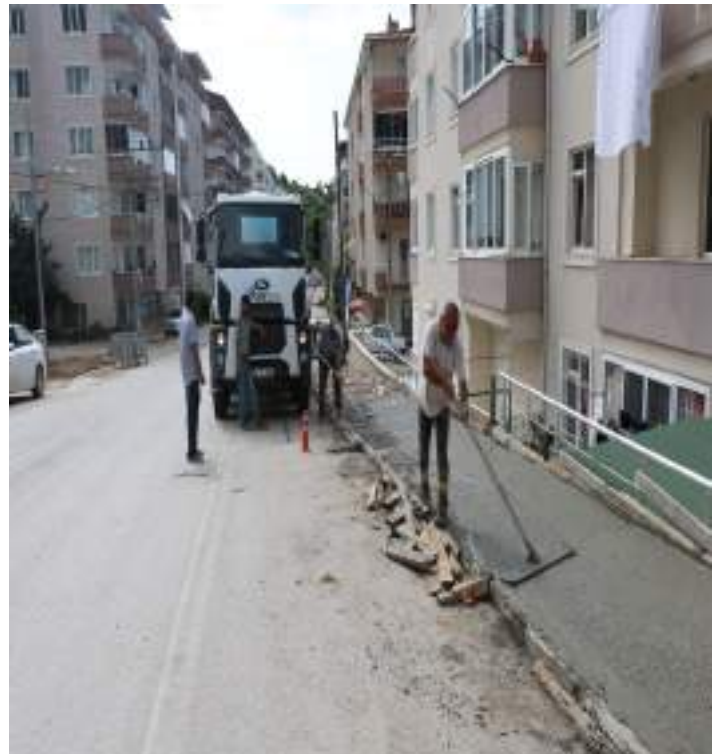
Poyraz Caddesi kaldırım çalışması
