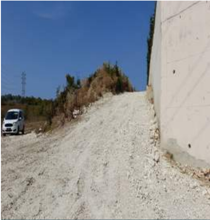
Yeni yol açma çalışmaları
