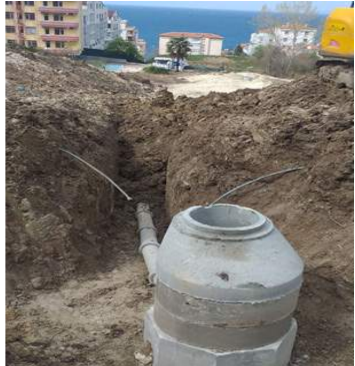
Yeni yağmur hattı ve ızgara yapımı
