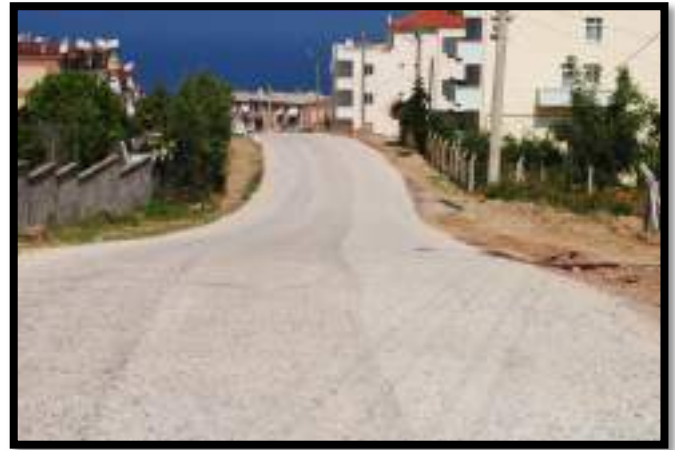
Hasanbaba yolu ve bariyerlerinin yapımı
