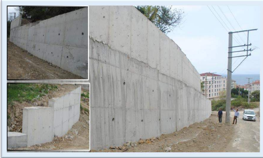
Çaldıran Sokakta istinat duvarı yapım işi.
