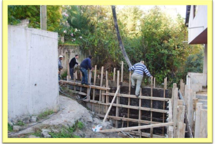
Nergiz Sokakta istinat duvarı yapım işi
